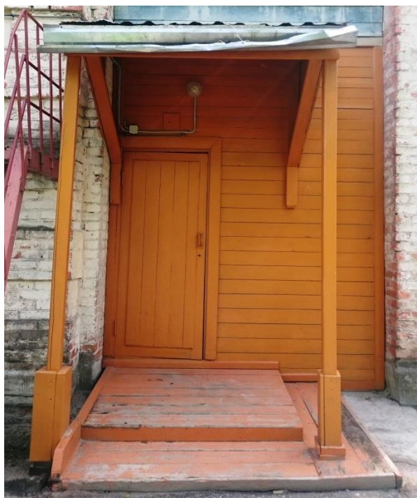
До проведения работ
