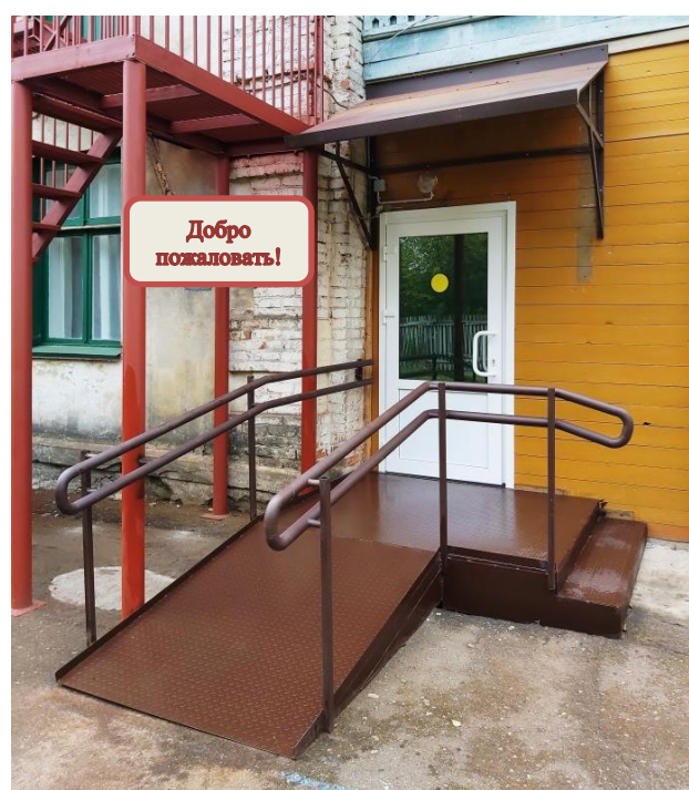
После проведения работ
